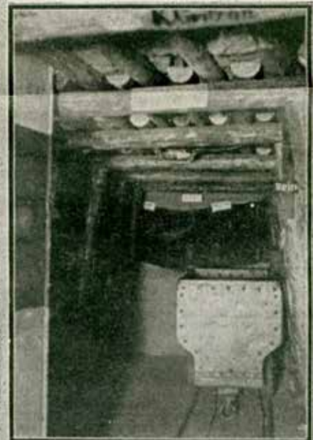
Förderstrecke mit nördlichem und südlichem Einfallen der Gesteine.
