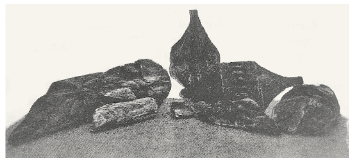
Abb. 4a/b: Im ehemaligen Zechenmuseum von Brad aufbewahrte Radwellen der in Ruda-Barza im Jahre 1892 entdeckten Wasserhebeeinrichtung.
