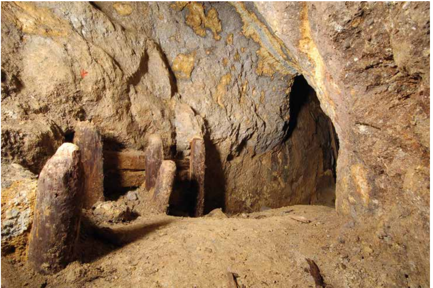
Abb. 15: Spuren der Sumpfeinfassung mit Grubenpfählen in der Radkammer C-1. (© Foto: Ivan Rous, 2013)
