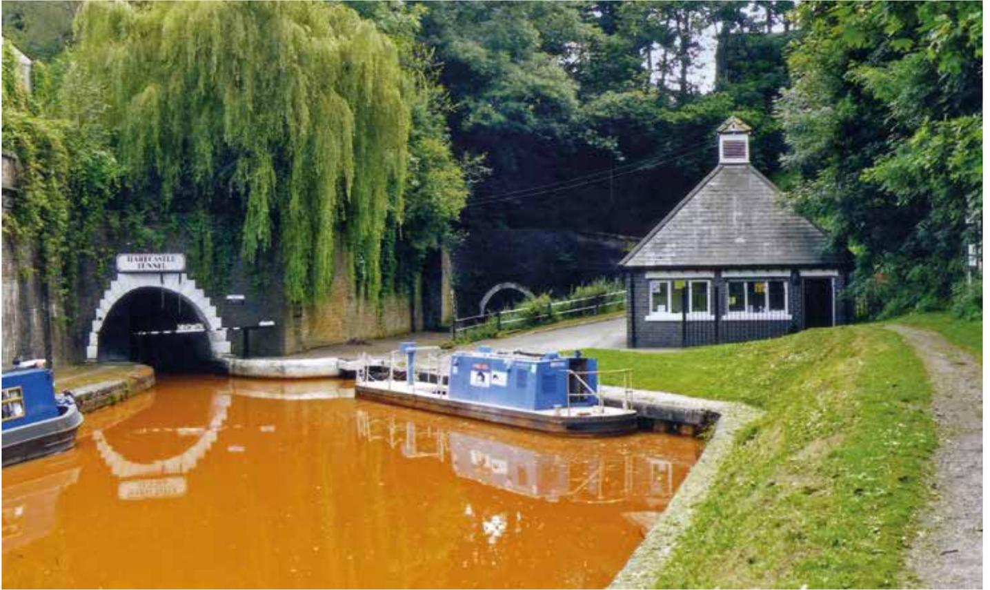
Abb. 1: Die beiden Harecastle-Schiffstunnel des Trent-and-Mersey-Canal: rechts das Mundloch des älteren, von James Brindley erbauten Schiffstunnels (1770-1777), links das des jüngeren, noch heute genutzten, von Thomas Telford aufgefahrenen Schiffstunnels (1825-1827). (© Foto: Rainer Slotta)
