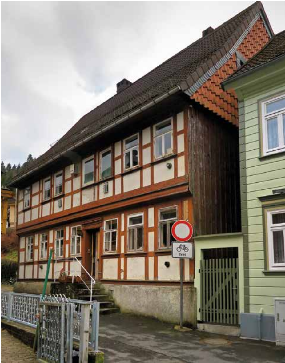
Abb. 4: Lautenthal (Stadt Langelsheim). An der Laute 28. Das Fachwerkhaus wurde im Vorfeld der Tagung dendrochronologisch untersucht und 1691/92 (d) datiert. Die Fassade wurde um die Mitte des 19. Jahrhunderts mit „Scheinfachwerk“ aus aufgenagelten Brettern verkleidet. (© Foto: Thomas Eißing)
