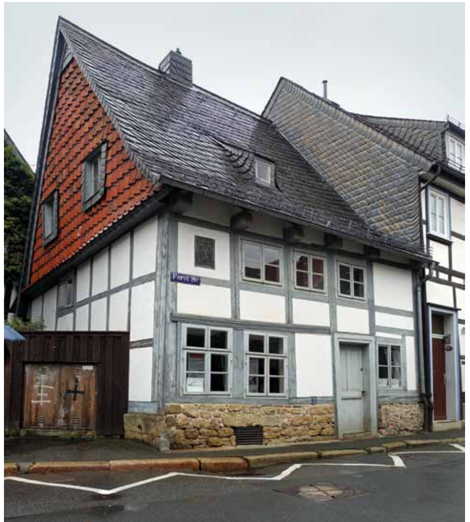
Abb. 3: Goslar, Forststr. 23. Typische „Bude“ des 16. Jahrhunderts, die zwischen etwa 1600 und 1900 von Bergleuten, Schiefergrubenarbeitern und Handwerkern bewohnt wurde. (© Foto: Heinrich Stiewe)
