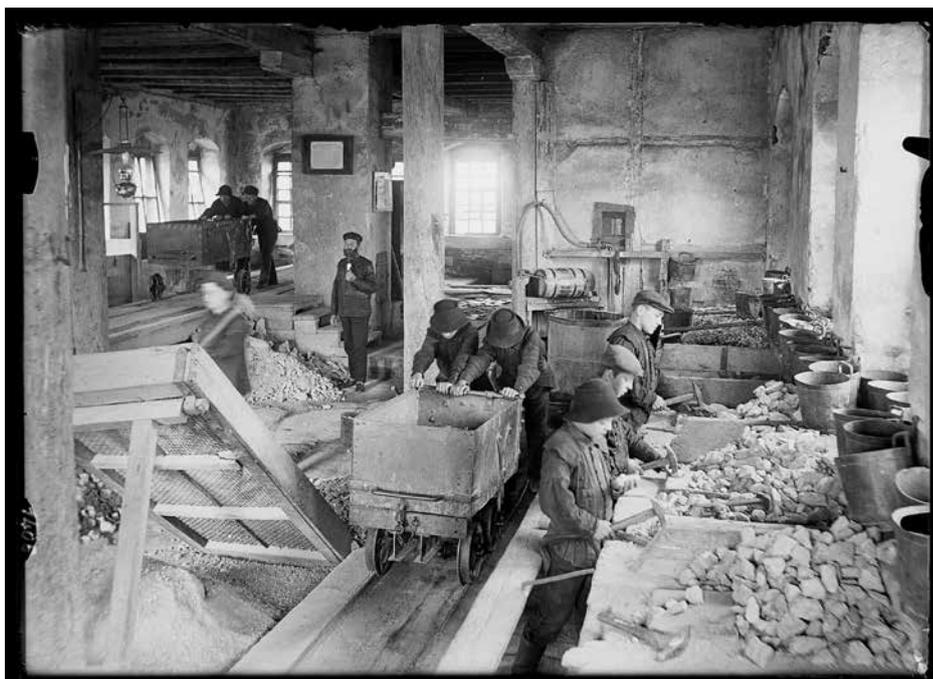
Abb. 14: Scheidebank vom „Abrahamschacht“. Hier standen die Scheidejungen täglich beim Zerkleinern des Gesteins im Staub. (© SBM Freiberg, Foto: Reymann, 1912)
