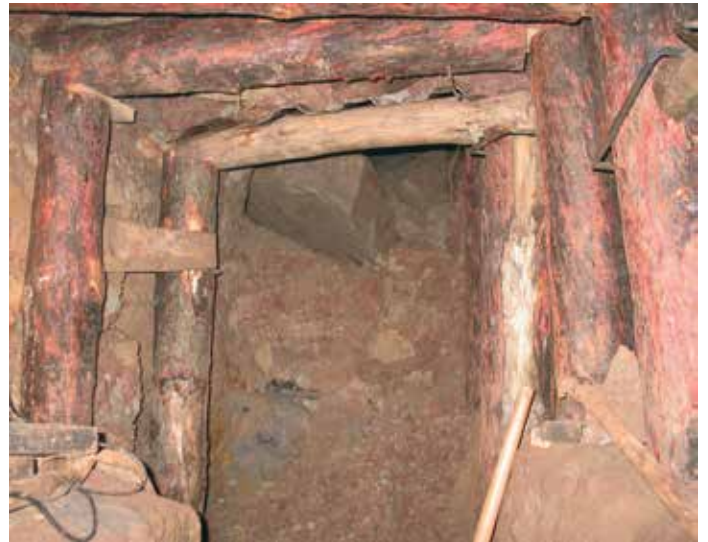
Abb. 9: Der verbrochene Bereich wurde zunächst durch Holzausbau gesichert, später durch gemauerte Bereiche. (© Foto: S. Müller, DBM)
