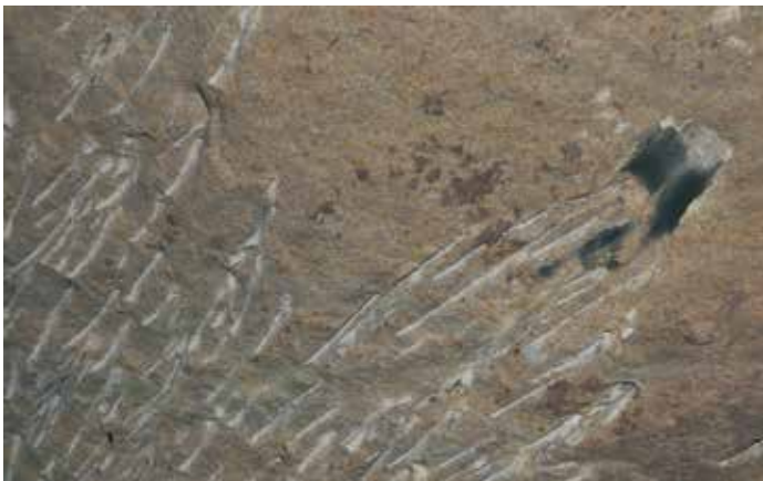
Abb. 28: An der Firste im Abbauraum finden sich Spuren von Picken und Keilen. (© Foto: G. Körlin, DBM)
