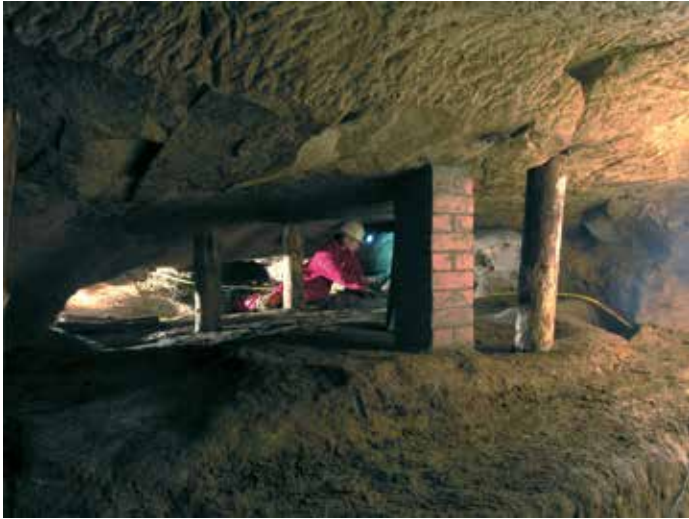
Abb. 14: Blick vom Stollen Bruss in den Abbauraum bei Lfm. 40-44. (© Foto: G. Steffens, DBM)
