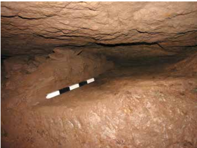
Abb. 13: Eine der Abbaunischen im linken Stoß des Stollens während der Freilegung. Links im Bild ist noch der Versatz, mit dem die Nische nahezu komplett verfüllt war. (© Foto: G. Körlin, DBM)
