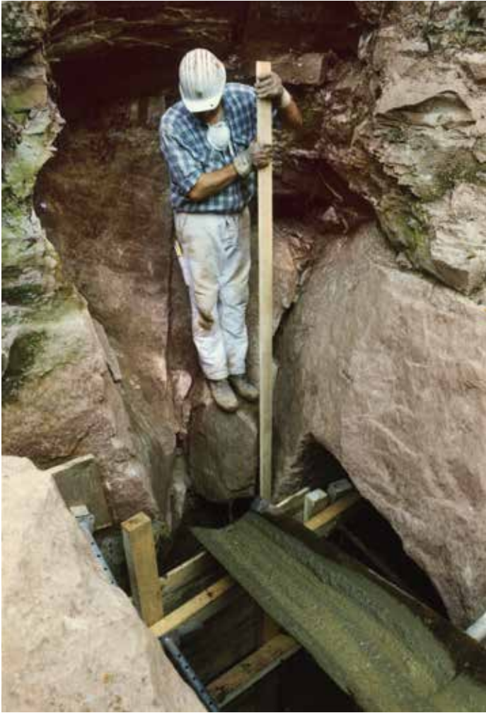
Abb. 7: Sicherungsarbeiten im Bereich des Mundlochs durch die Bergleute des DBM. (© Foto: S. Müller, DBM)
