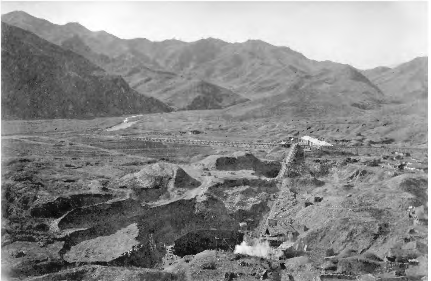
Abb. 5: Die Goldwaschanlage im „Tiefen Loch“ von Danggogae. Im Vordergrund ist die schiefe Ebene sichtbar. Die Loren werden an einem Seil mit Hilfe der Dampfmaschine hochgezogen. Von rechts wird mittels eines Kanals auf einem Holzgerüst das Wasser zugeführt. Die Erde wird in die Rinne gekippt und durch das Wasser über eine weitere Holzrinne, die immer wieder mit querstehenden Stabeisen beschlagen ist, zum Fluss (links) transportiert. Diese Holzrinne wird von Louis Bauer als „Sluices“ bezeichnet. Vor den Stabeisen bleiben die schweren Goldkörner zusammen mit Erde liegen. Diese goldhaltige Erde wird danach in den Holzpfannen gewaschen. (© Foto: Louis Bauer/TU Bergakademie Freiberg, Geowissenschaftliche Sammlungen)
