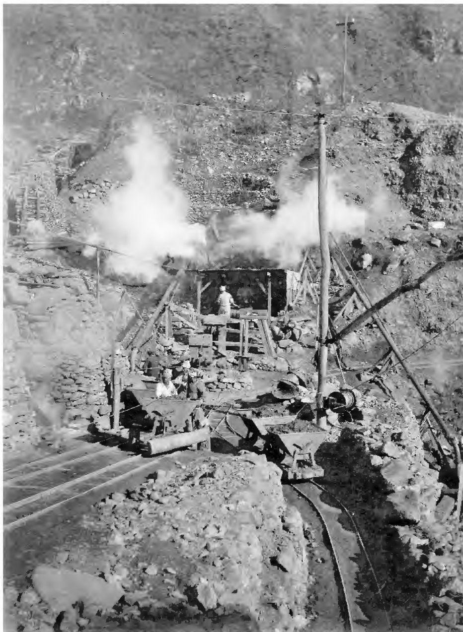
Abb. 4: Die mit goldhaltigen Schotter beladenen Loren werden mit Hilfe eines dampfbetriebenen Zugseils auf einer Rampe abtransportiert. (© Foto: Louis Bauer/Familiensammlung Prof. Andreas Pistorius)
