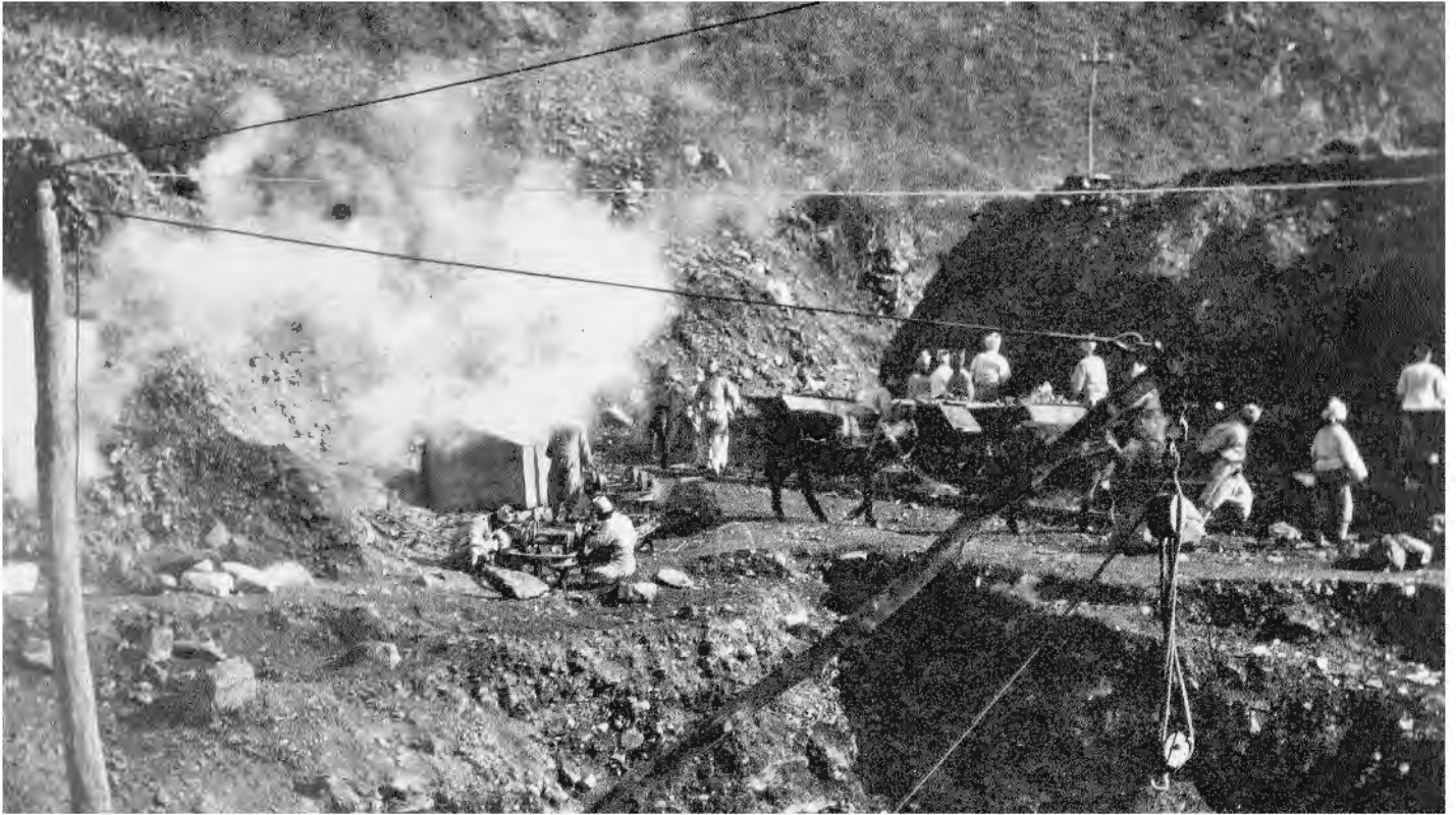
Abb. 2: Die Radsätze der Loren erforderten aufgrund des schlechten Untergrunds eine regelmäßige Wartung. (© Foto: Louis Bauer/Familiensammlung Prof. Andreas Pistorius)
