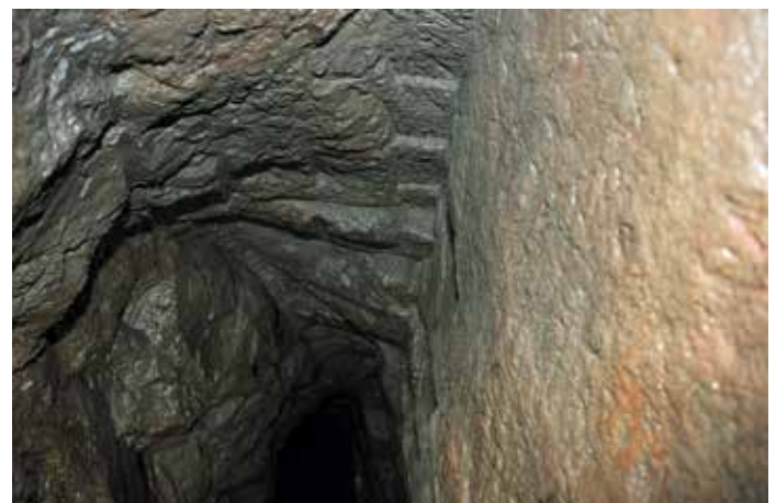
Abb. 25: Blick auf die unsymmetrische Form der Wände, Mine St-Jean, Le Thillot. (© Foto: SÉSAM)
