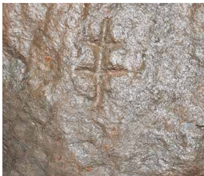
Abb. 46: Doppertes Markscheidekreuz, Mine St-Jean, Le Thillot. (© Foto: SÉSAM)
