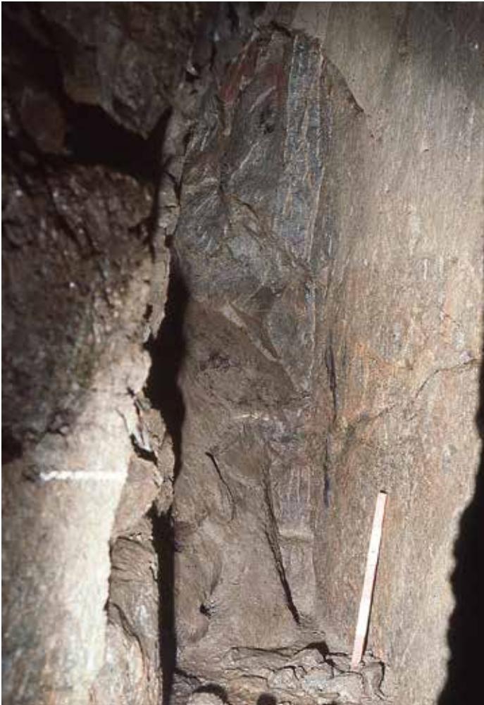
Abb. 15: Ortsbrust der Mine St-Laurent, Le Thillot. (© Foto: SÉSAM)
