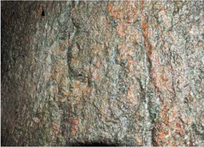
Abb. 17: Kerbe in der Wand für die Bohrerstütze in der Mine St-Laurent, Le Thillot. (© Foto: SÉSAM)
