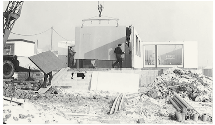
Abb. 8: Zenker-Fertighaus in der Professorensiedlung in Bochum im Bau o. J. (Universitätsarchiv Bochum, Dep. Staatl. Bauamt Bochum 02, FA-Nr. 69, Az 0/122/7520, Sofortprogramm, 66.0072 (© Bau- und Liegenschaftsbetrieb NRW))
