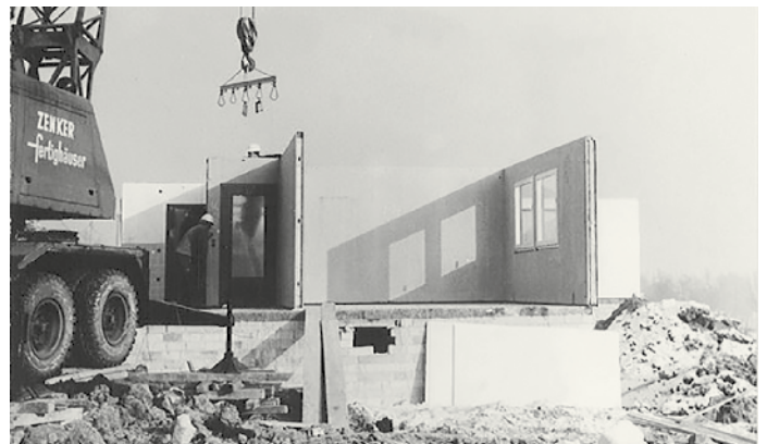
Abb. 10: Zenker-Fertighaus in der Professorensiedlung in Bochum im Bau o. J. (Universitätsarchiv Bochum, Dep. Staatl. Bauamt Bochum 02, FA-Nr. 69, Az 0/122/7520, Sofortprogramm, 66.0083 (© Bau- und Liegenschaftsbetrieb NRW))
