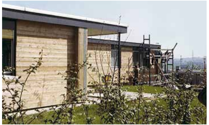
Abb. 12: Krupp-Fertighäuser in der Professorensiedlung in Bochum, Bearbeitung Außenwände o. J. (Universitätsarchiv Bochum, Dep. Staatl. Bauamt Bochum 02, FA-Nr. 69, Az 0/122/7520, Sofortprogramm, 66.0438 (© Bau- und Liegenschaftsbetrieb NRW))
