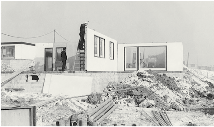
Abb. 7: Zenker-Fertighaus in der Professorensiedlung in Bochum im Bau o. J. (Universitätsarchiv Bochum, Dep. Staatl. Bauamt Bochum 02, FA-Nr. 69, Az 0/122/7520, Sofortprogramm, 66.0071 (© Bau- und Liegenschaftsbetrieb NRW))
