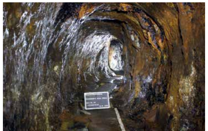
Abb. 7: Runde Form des Querschlages am Beginn des Abzweigs vom Rathstiefsten Stollen. (© Foto: G. Drechsler/NLD)
