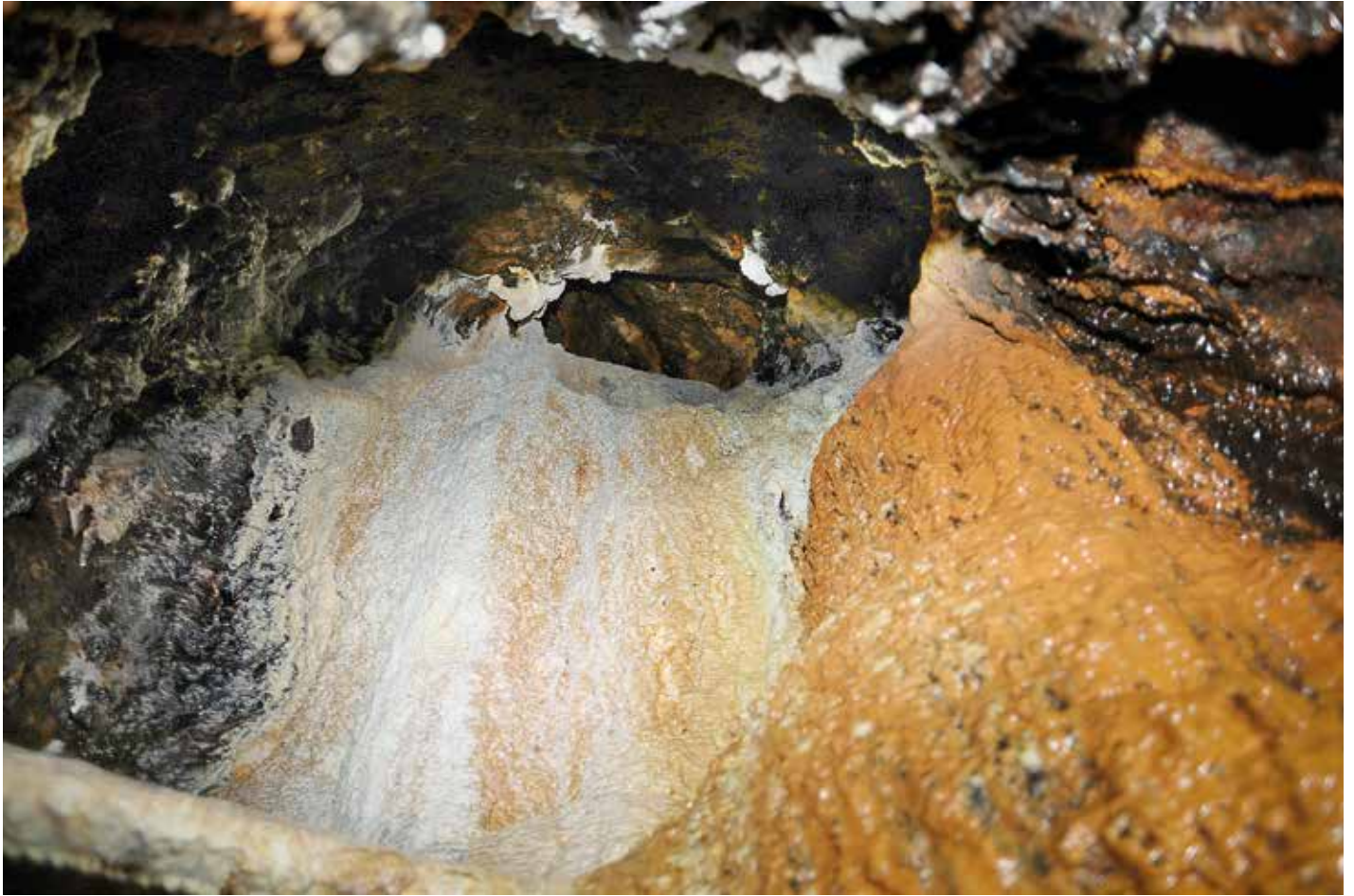
Abb. 14: Blick von unten in den Hochbruch auf die vermeintliche Firste. (© Foto: J. Meyer/TU Clausthal)
