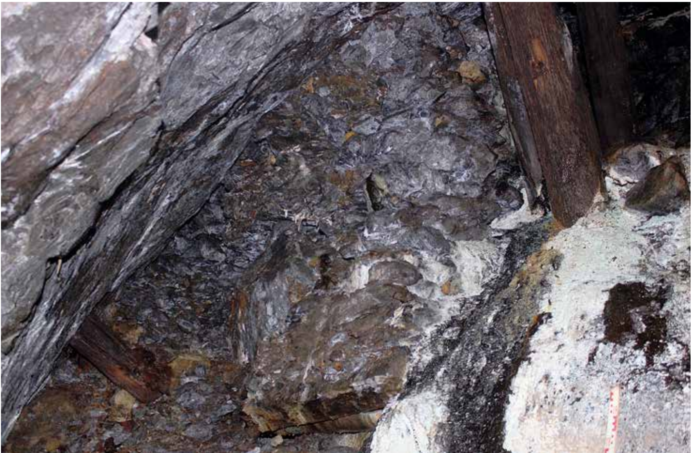
Abb. 10: Verfüllmasse aus regellos liegenden Bruchsteinen. (©Foto: G. Drechsler/NLD)
