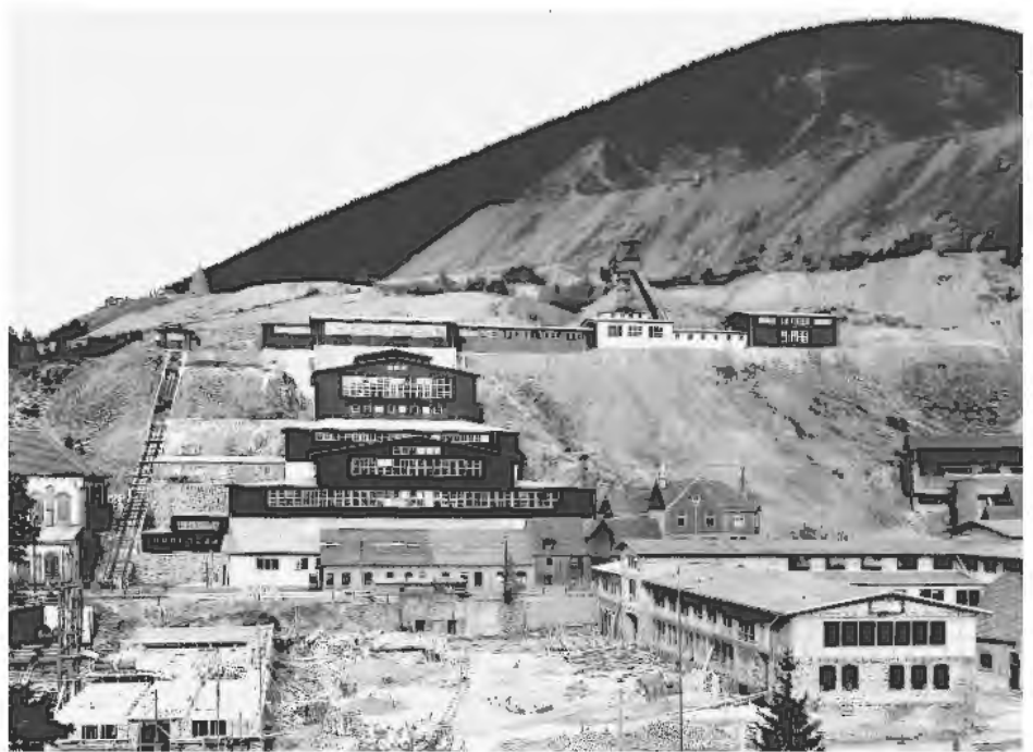
Abb. 1: Die im Bau befindlichen Tagesanlagen des Erzbergwerkes Rammelsberg 1937. (© Foto: Sammlung Weltkulturerbe Rammelsberg)
