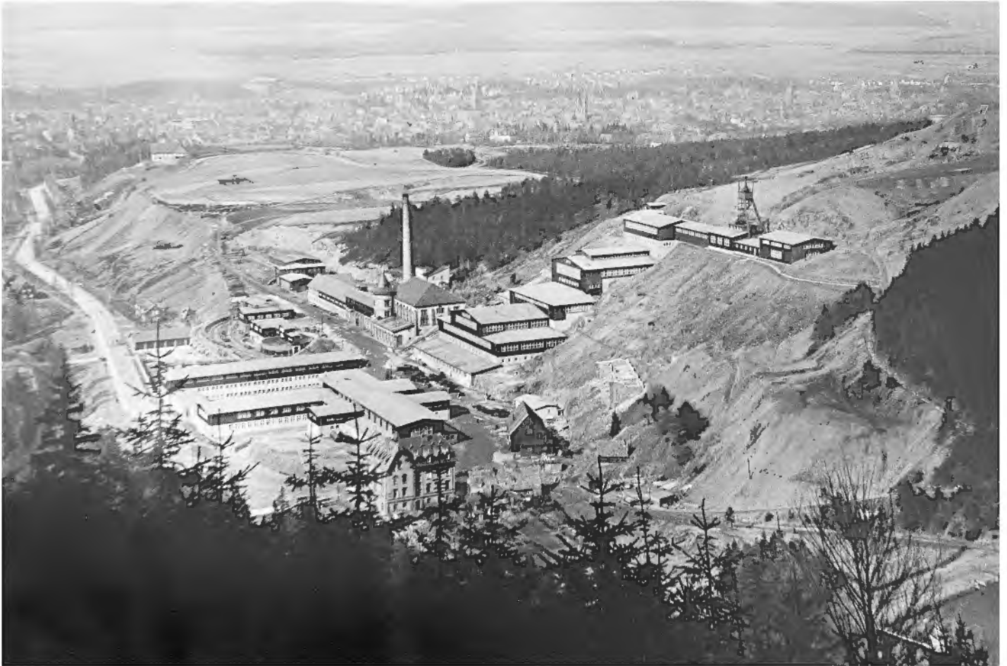
Abb. 4: Luftbild der Tagesanlagen des Erzbergwerks Rammelsberg, ca. 1941. (© Foto: Sammlung Weltkulturerbe Rammelsberg, Archiv Fritz Schupp Köln)
