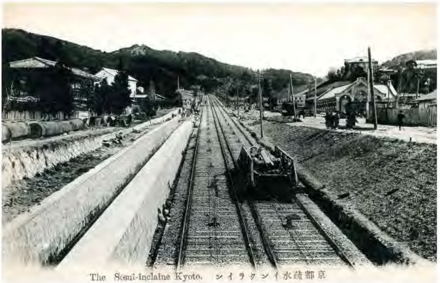
Abb. 2: Kyoto (Japan), Schrägaufzug des Biwa-Kanals. Im Hintergrund (rechts) das Wasserkraftwerk. (Historische Postkarte)
