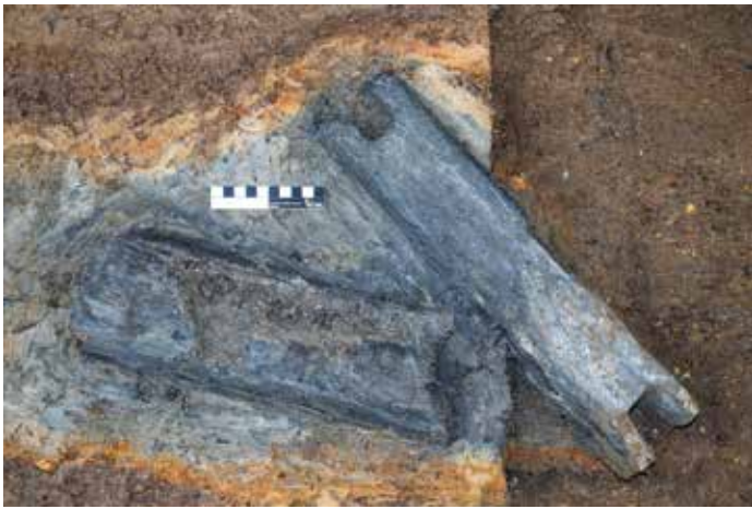
Abb. 16: Shashkoc/Šaškovac: Die gut erhaltenen Ausbauhölzer vor dem Stollenmundloch von Stollen 9. (© Foto: G. Körlin, DBM)
