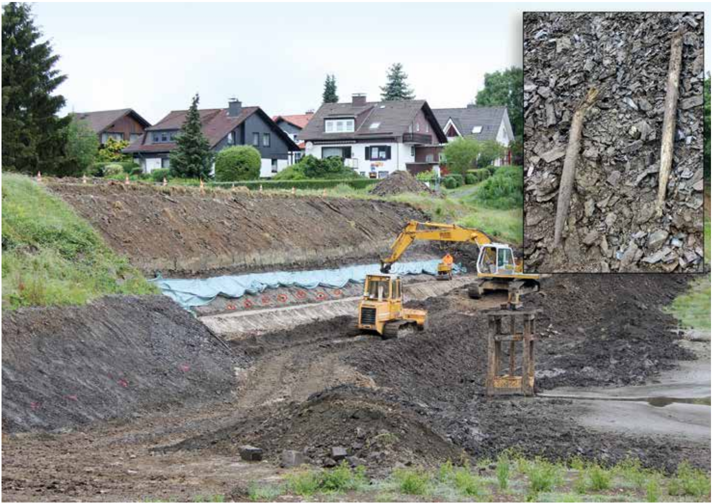
Abb. 23: Wasserseitiger Blick auf die Dammmauer mit regelmäßigen Holzpfählen (rote Kreise). (© Foto: G. Drechsler, NLD)
