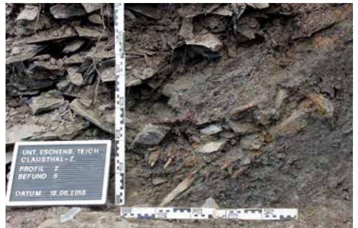
Abb. 22: Querprofil des Dammes mit erhaltenem Astwerk einer alten Wellenschutzschicht unter der neuen aus Bruchsteinen. (© Foto: G. Drechsler, NLD)
