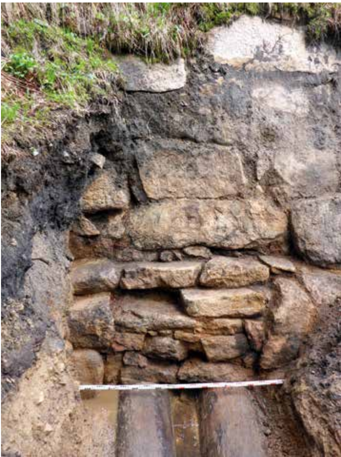
Abb. 15: Ein zugemauertes Stollenmundloch zeigt den ehemaligen Zugang zu den beiden Gerennen aus Holz. (© Foto: K. Malek, NLD)
