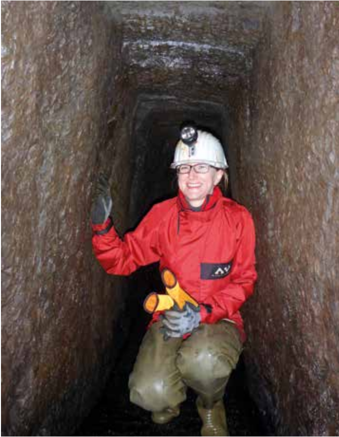
Abb. 10: Blick in den engen, aber sauber durch Handarbeit ausgeschrägten Johann Friedricher Wasserlauf. (© Foto: A. Pfau, Harzwasserwerke GmbH)
