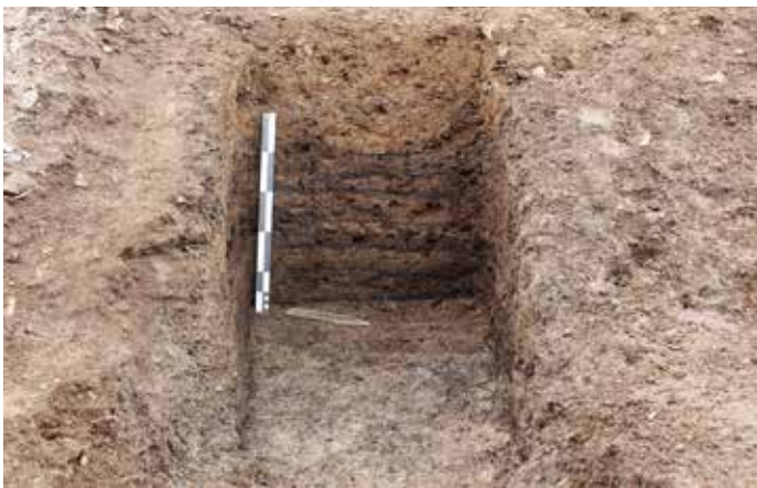
Abb. 24: Oberer Sondageschnitt am Bärenbrucher Teich mit gut erkennbaren Rasensoden und der darüber liegenden Ausgleichsschicht zur Stein-schüttung des Wellenschutzes. (© Foto: G. Drechsler, NLD)
