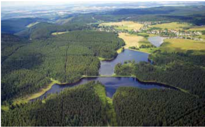
Abb. 13: Teichkaskade mit dem Bärenbrucher Teich im Vordergrund. (© Foto: V. Gawehn, Harzwasserwerke GmbH)
