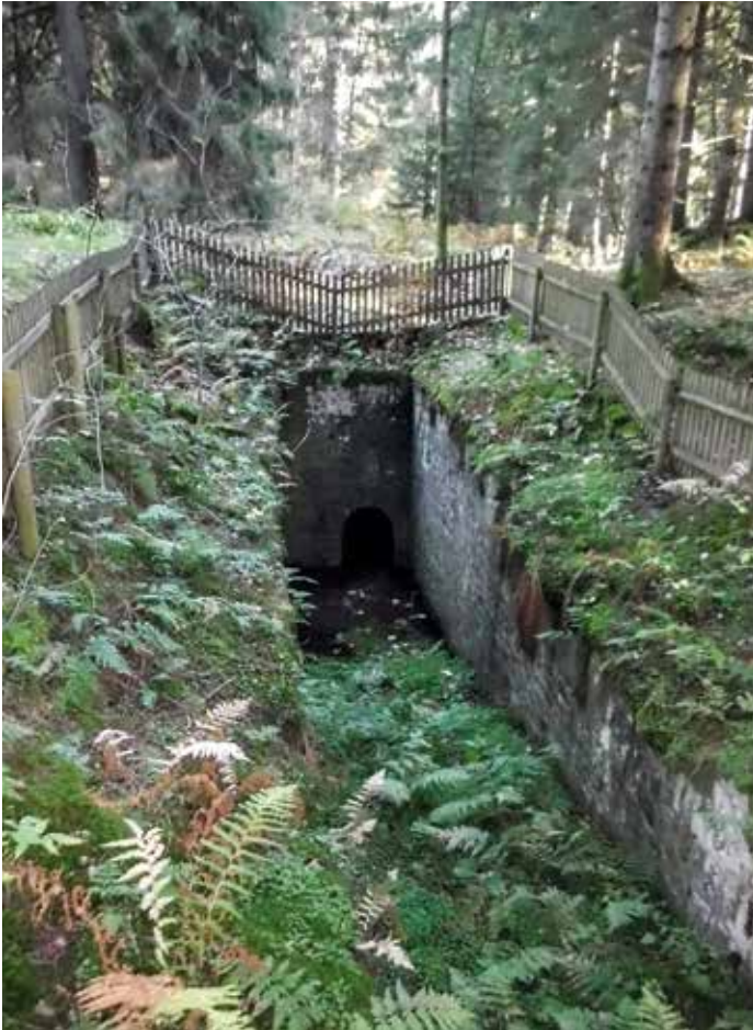
Abb. 29: Beispiel einer ausgemauerten übertägigen Radstube im Polstertal (© Foto: T. Schröpfer, NLD)
