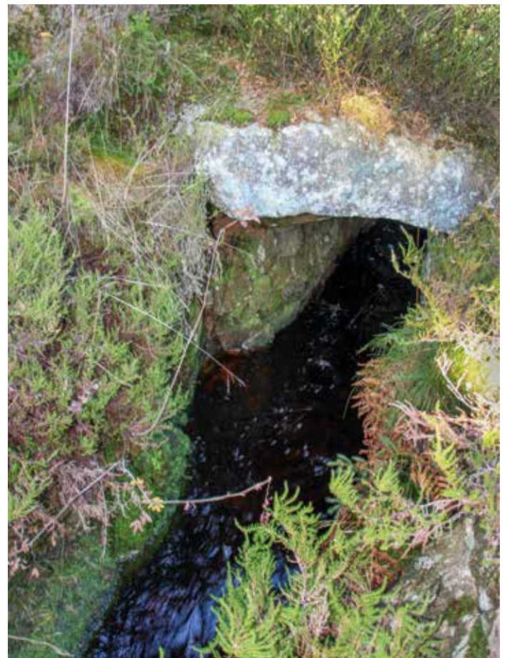
Abb. 5: Abdeckung des Neuen Rehberger Grabens mit Steinplatten. (© Foto: K. Malek, NLD)
