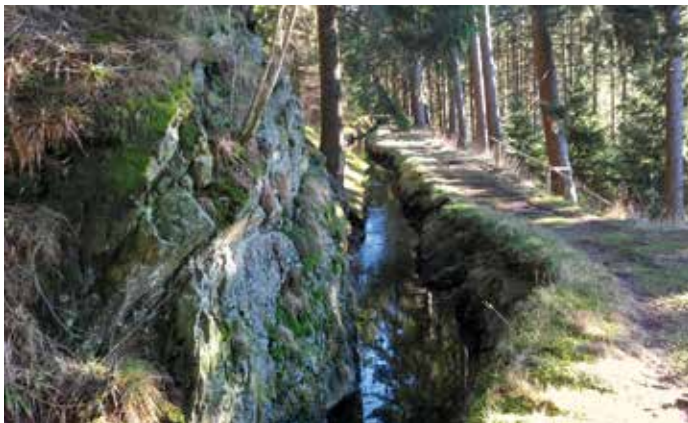
Abb. 4: Aus dem Fels ausgehauener Grabenverlauf am Morgenbrodthaler Graben. (© Foto: K. Malek, NLD)
