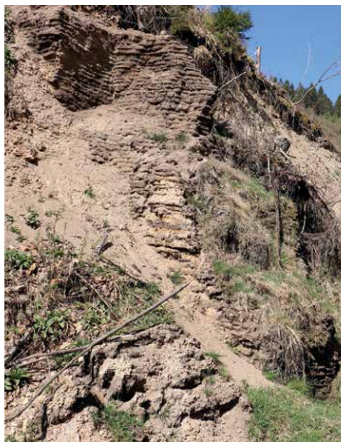
Abb. 26: Mauerartig ragt die gut 13 m hoch erhaltene Innendichtung aus Rasenplacken aus dem erodierten Dammkörper hervor. (© Foto: Katharina Malek, NLD)
