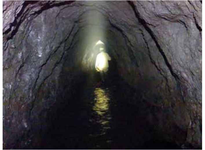
Abb. 11: Geradlinige und breite Auffahrung des Rothenberger Wasserlaufes durch Schiebarbeit. (© Foto: K. Malek, NLD)
