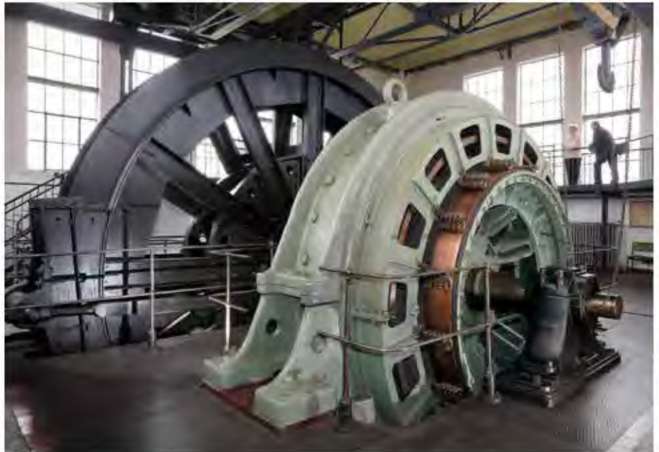
Abb. 3: Turmfördermaschine. (© P. Franke)
