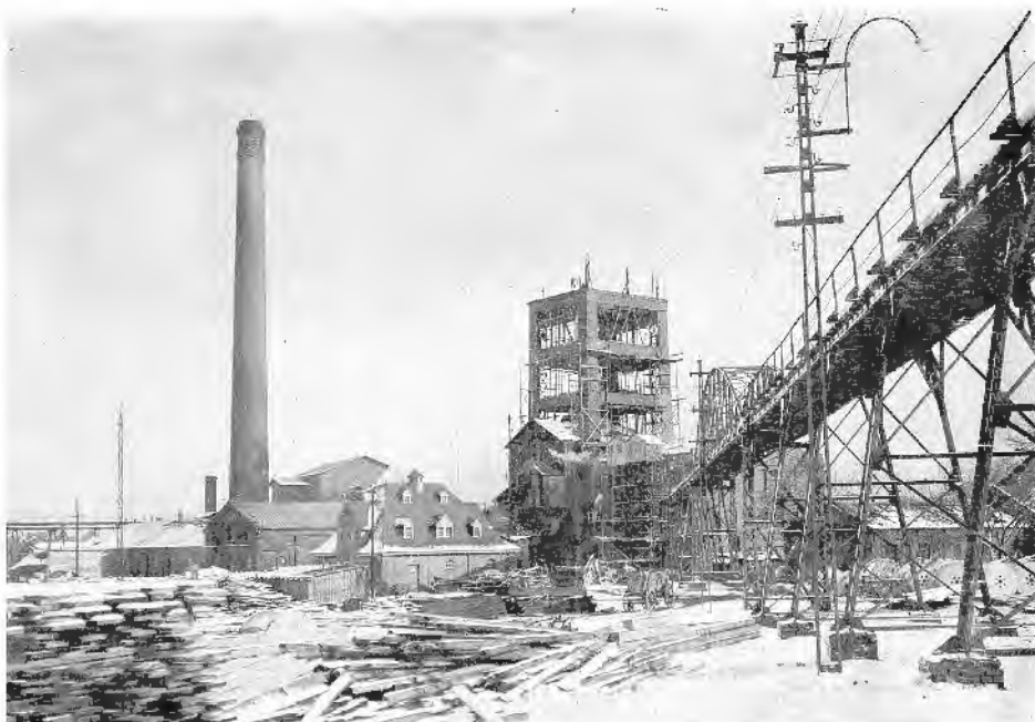
Abb. 4: Bau des Förderturmes des Kaiserin-Augusta-Schachtes 1923. (© BBMOe)
