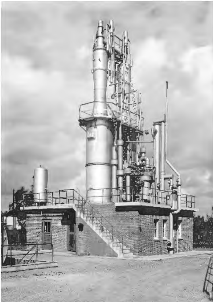
Abb. 12: Gaswerk Coesfeld: Ölspaltanlage, September 1955. (© Foto: thyssenkrupp Corporate Archives, Duisburg (FG/1927))
