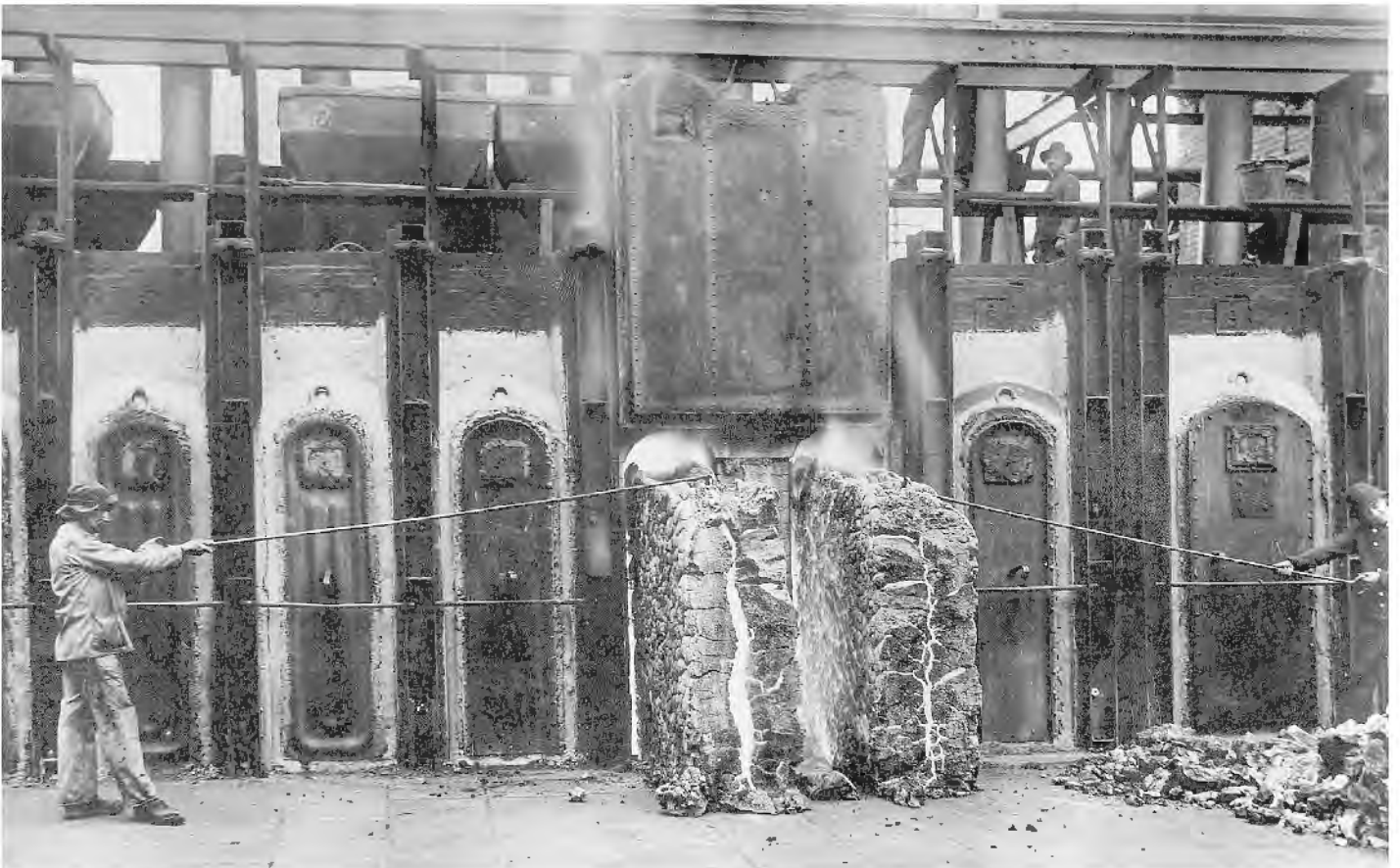
Abb. 2a: Alte Versuchsanlage Dahlhausen, 1914: Kokslöschen eines Doppelofens, erbaut 1901. (© Foto: thyssenkrupp Corporate Archives, Duisburg (FG/2093))
