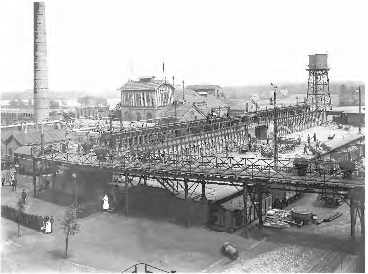
Abb. 3: Zeche König Ludwig, Recklinghausen: 60 Unterfeuerungskoksöfen mit Nebengewinnung, o. D. (© Foto: thyssenkrupp Corporate Archives, Duisburg (FG/2210))
