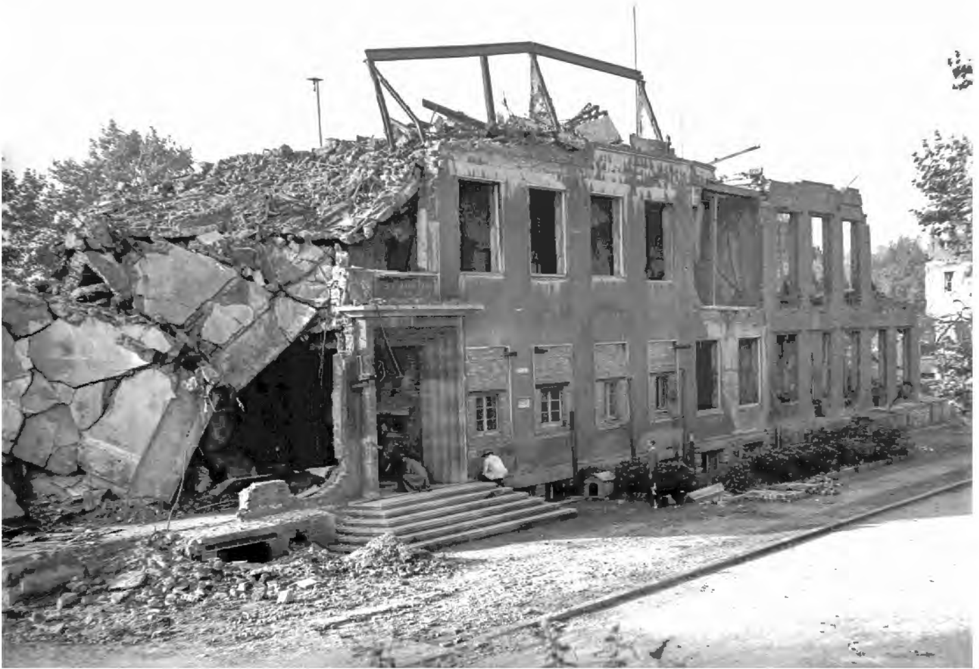
Abb. 6: Bombenschäden am Bürogebäude in Bochum. (© Foto: thyssenkrupp Corporate Archives, Duisburg (FG/3189))
