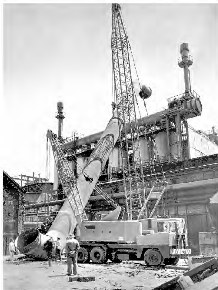
Abb. 13: Rohrmontage, o. D. (© Foto: thyssenkrupp Corporate Archives, Duisburg (FG/3417))
