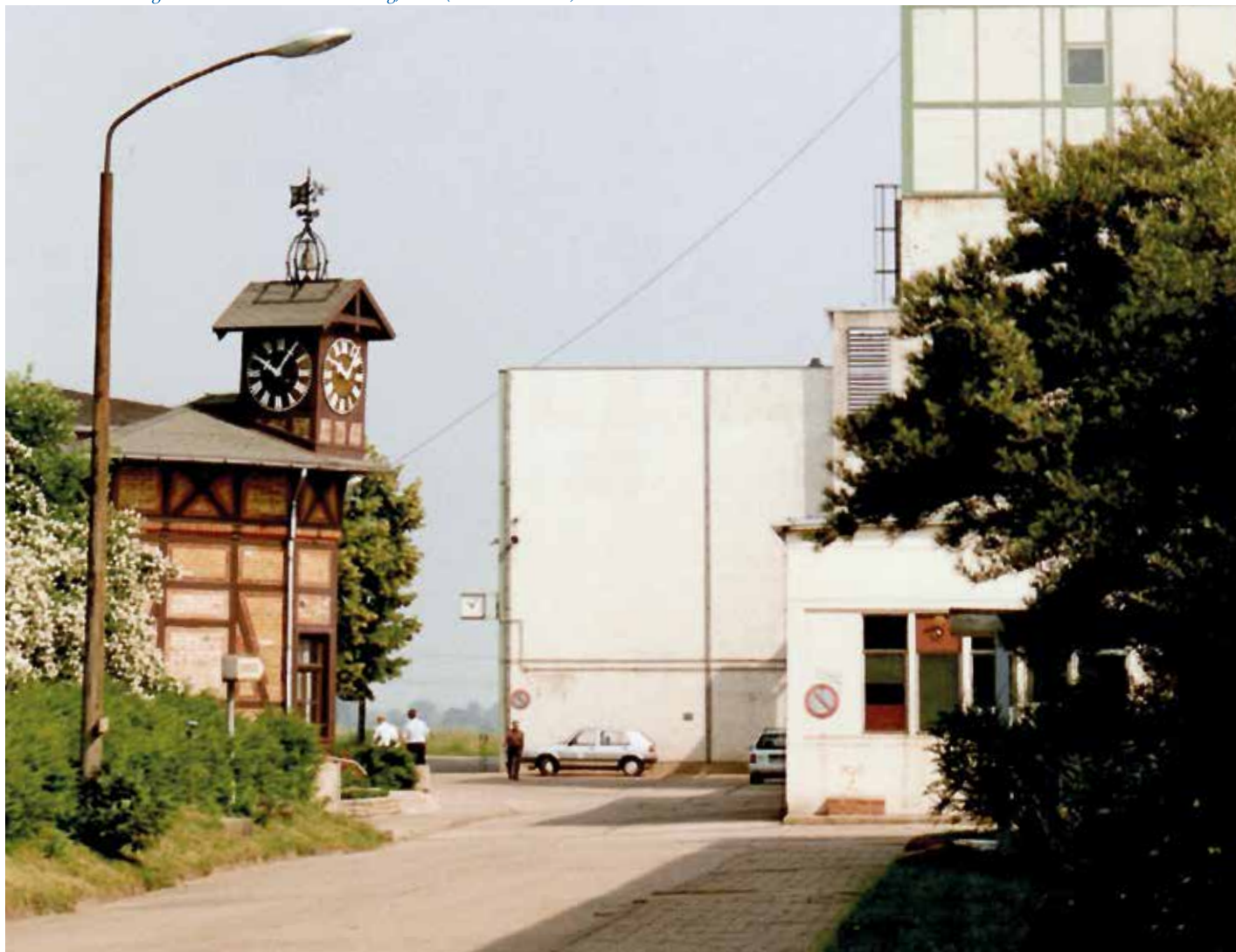
Abb. 2: Das Pförtnergebäude nach der Instandsetzung, 1984. (© Foto: DEWAG)
