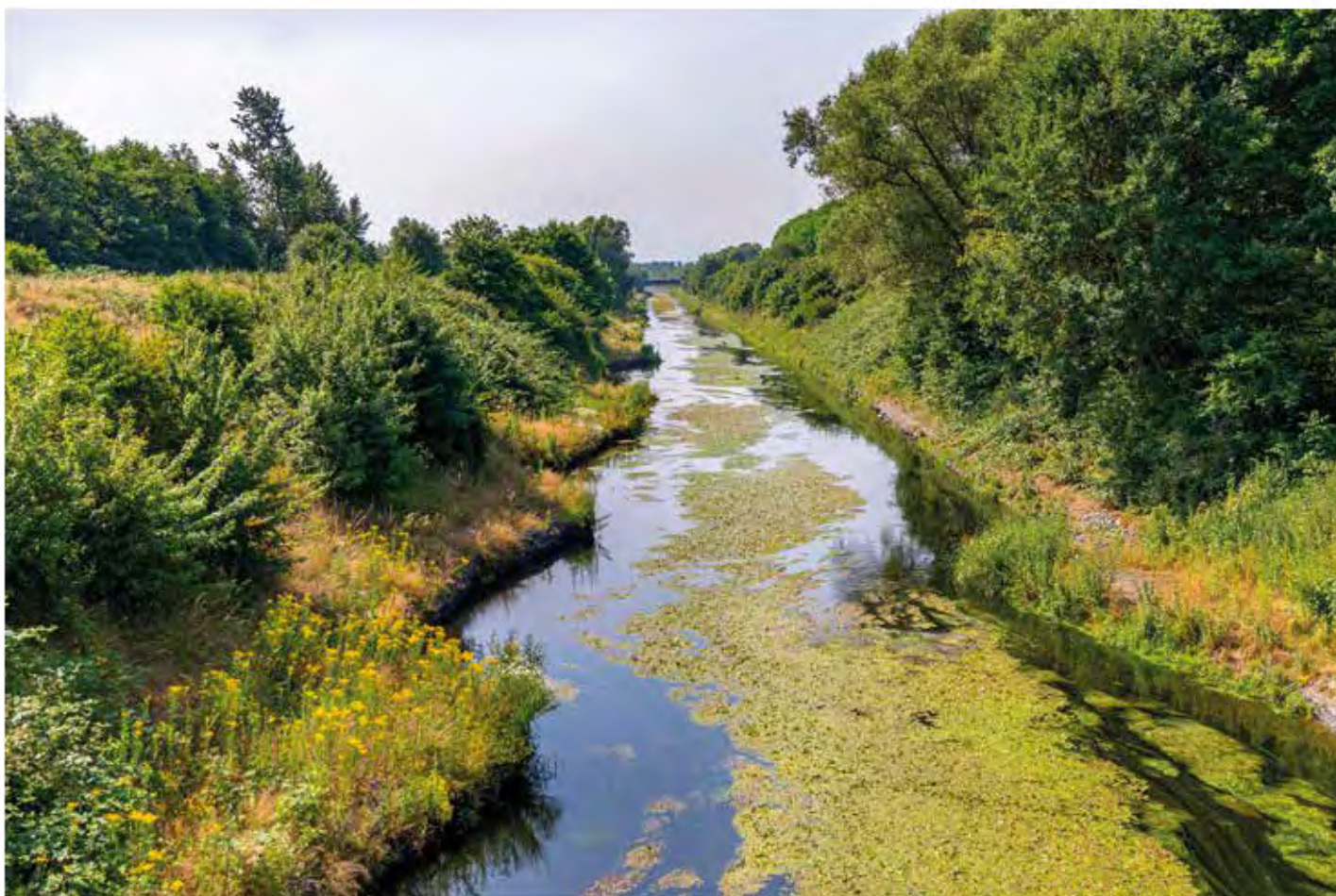
Abb. 6. Versuchsstrecke Emscher-Umbau Dortmund-Deusen, 22. Juni 2017. (© Jannis Reichard/ Emschergenossenschaft)
