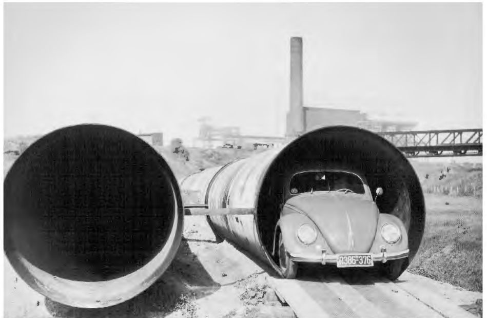
Abb. 3. Baustelle am Pumpwerk Alte Emscher, Duisburg, um 1953. (© Emschergenossenschaft)
