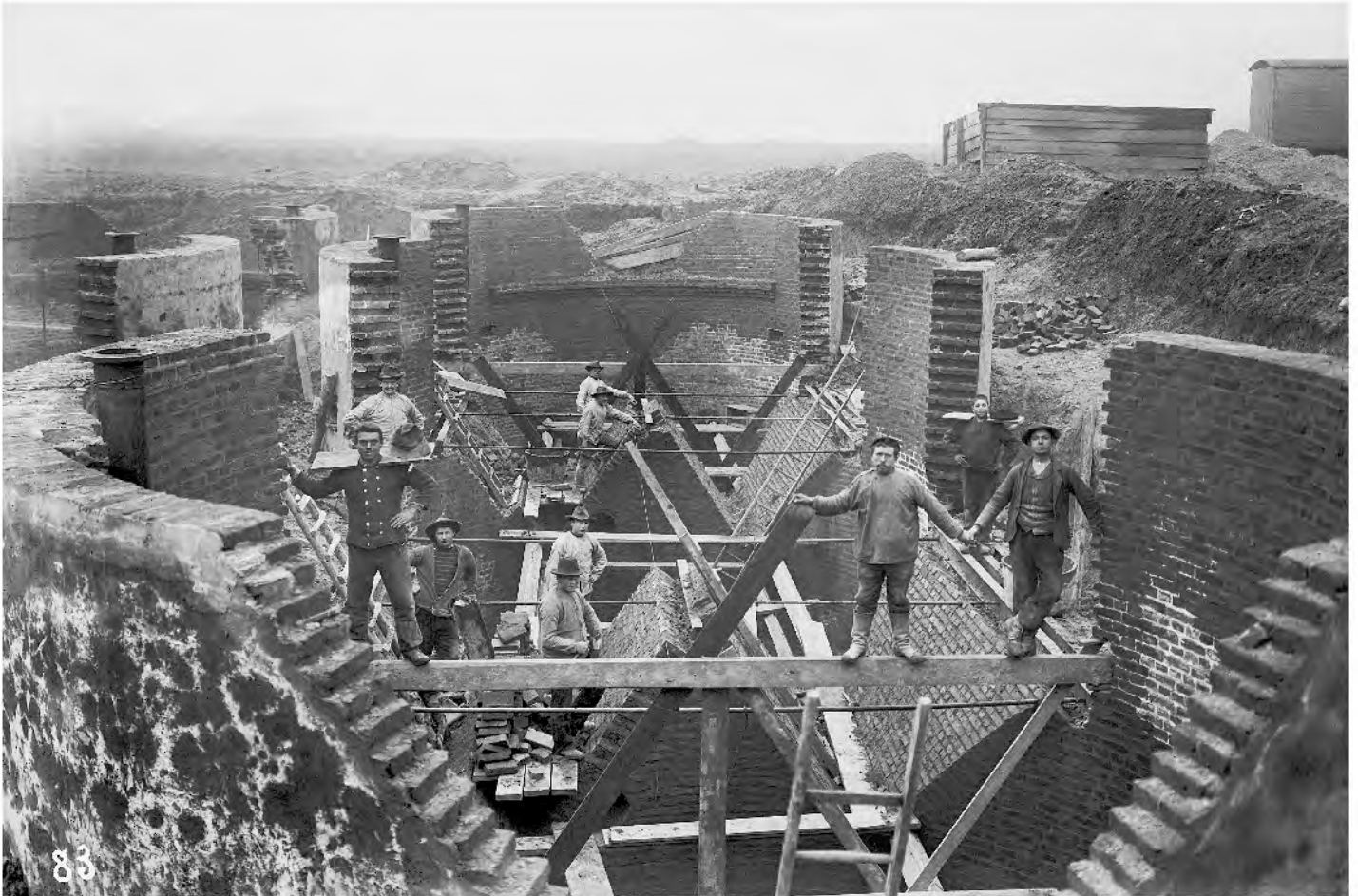
Abb. 4. Kläranlage Bochum: Emscherbrunnen im Bau, um 1907. (© Emschergenossenschaft)
