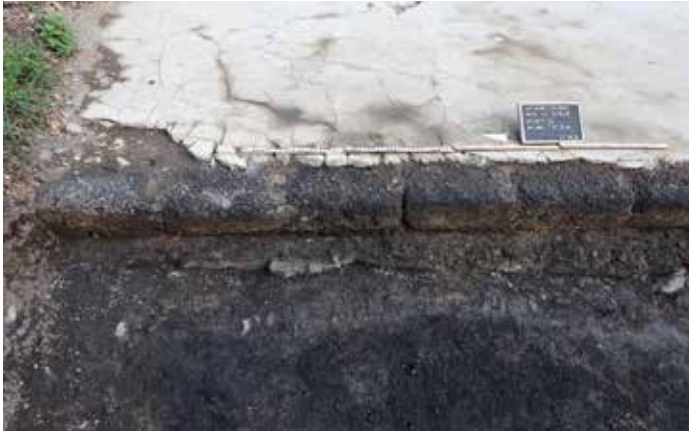
Abb. 16: Aufbau der Westmauer der Wasch- und Abortbaracke. (© Foto: G. Drechsler/NLD)
