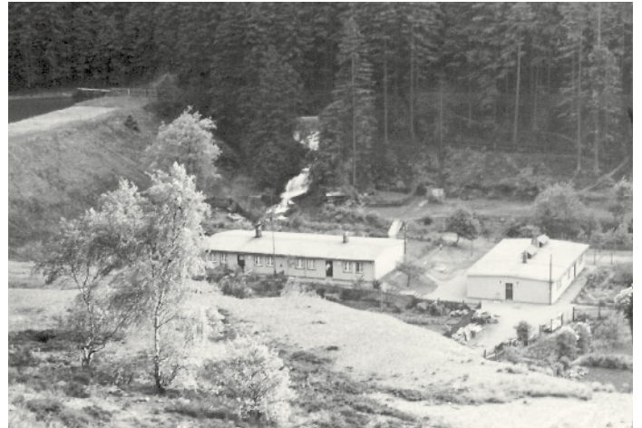
Abb. 11: Nachkriegszeitliche Fotografie der Westarbeiter- und der Wasch- und Abortbaracke mit verputzten Außenwänden. (© Sammlung Weltkulturerbe Rammelsberg)
