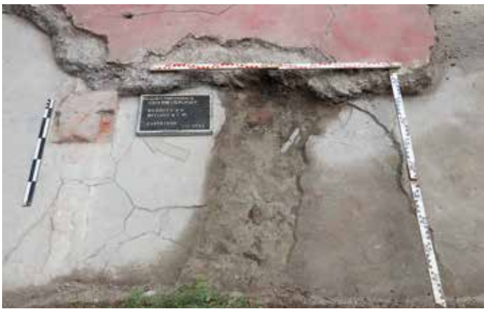
Abb. 22: Betonsockel mit roten Anstrich im Anbau der Wasch- und Abortbaracke. (© Foto: K. Malek-Custodis/NLD)
