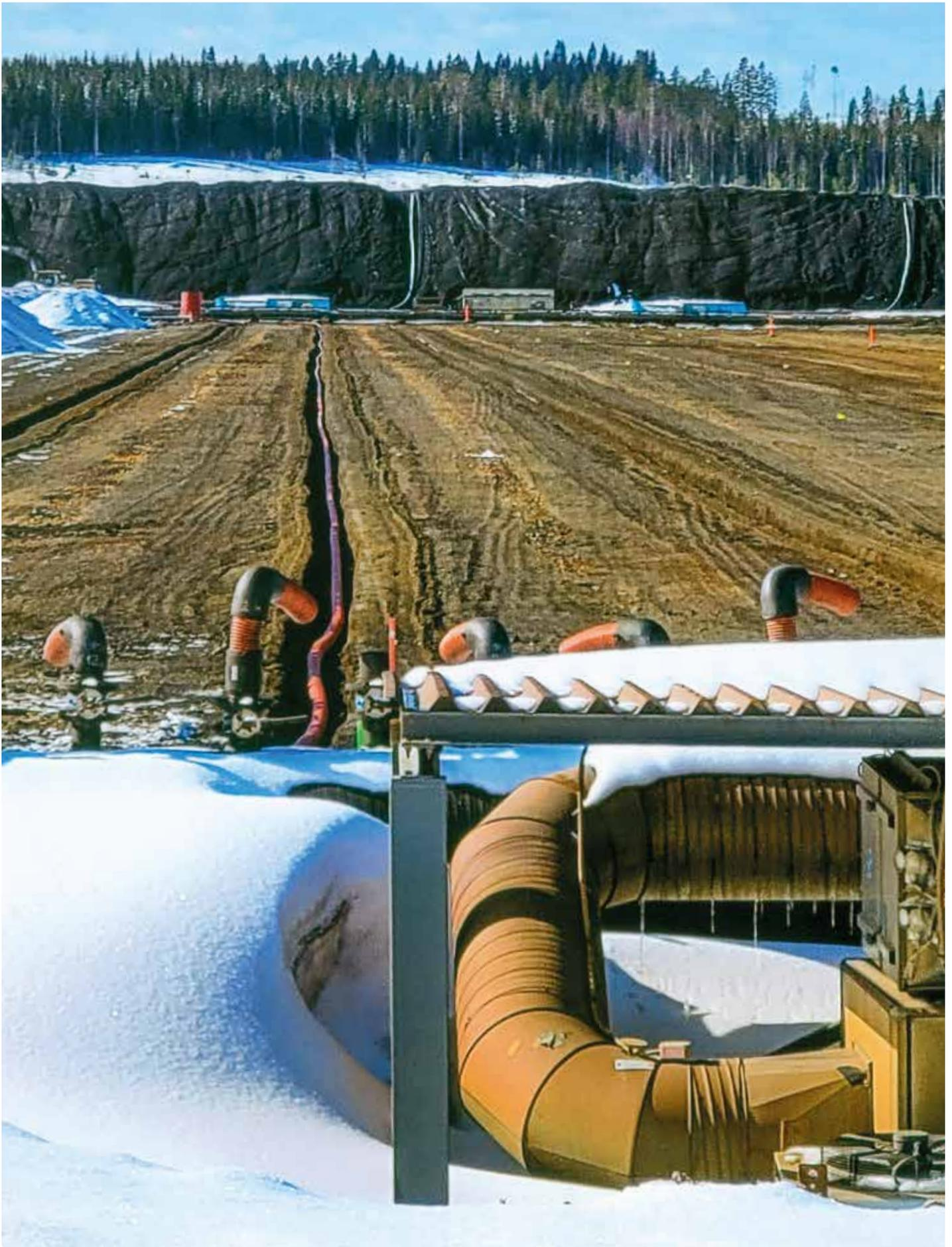
Abb. 5: Planierungs- und Drainagearbeiten für eine neue Halde im Freien. (© Foto: Lorenz Rothe)
