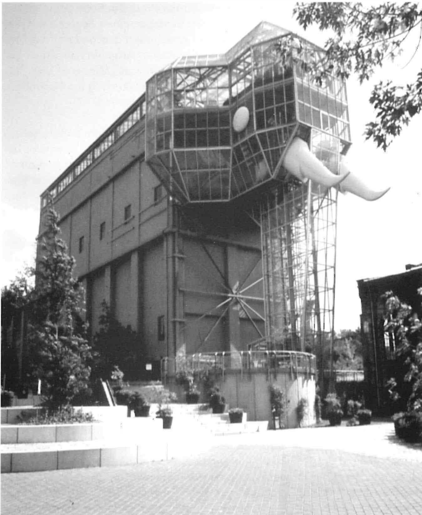
Abb. 3: Noch ein Industriedenkmal? Die im Zuge der Landesgartenschau zum Elefanten umgebaute Kohlenwäsche der ehemaligen Grube Maximilian in Hamm.
